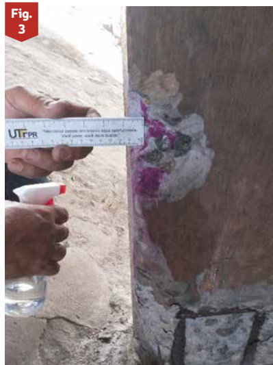
Ensaio de carbonatação com uso de fenolftaleína em obra de viaduto
