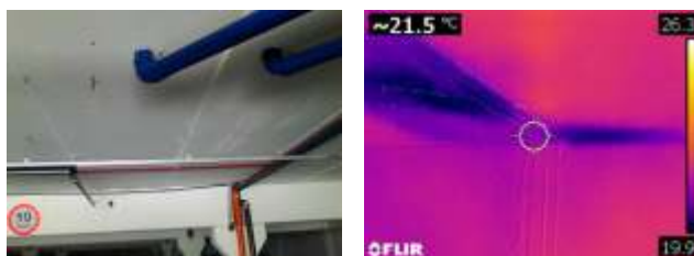
FOTO 08 – Termografia em laje nervurada
