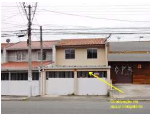
Foto 10 – Casa construída no recuo obrigatório.
