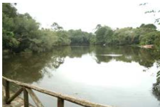
Foto 2 – vista do lago a partir da barragem
